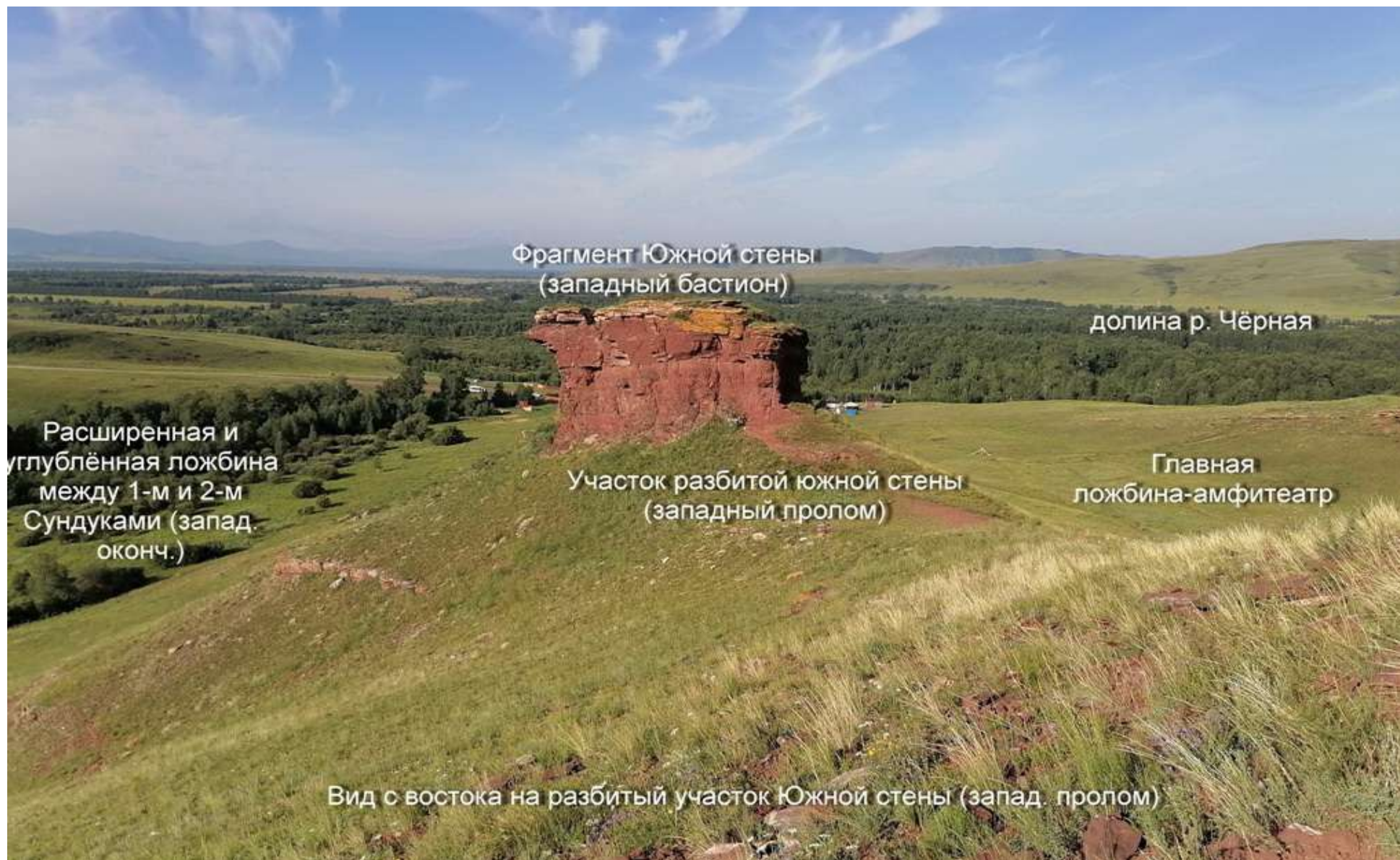
Фото 8. Вид с востока на разбитый участок Южной стены (западный пролом)
